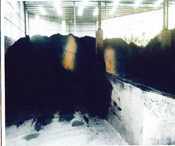
炭黑堆场及事故池
