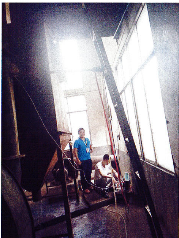
锅炉出口废气监测
