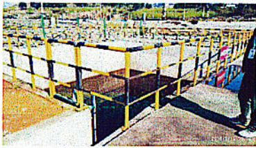
西北侧雨水收集池 300m 3
