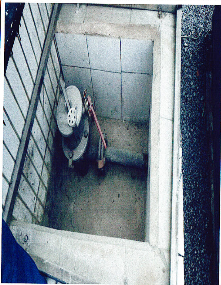
油气回收装置
