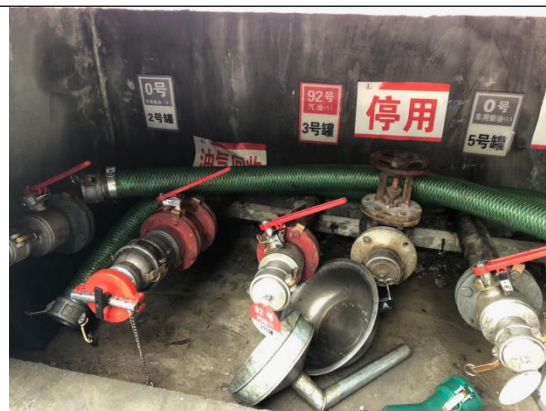
油气回收装置
