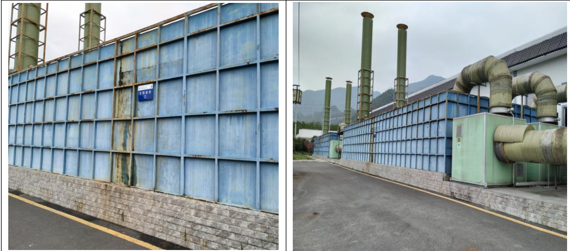
生物除臭系统
