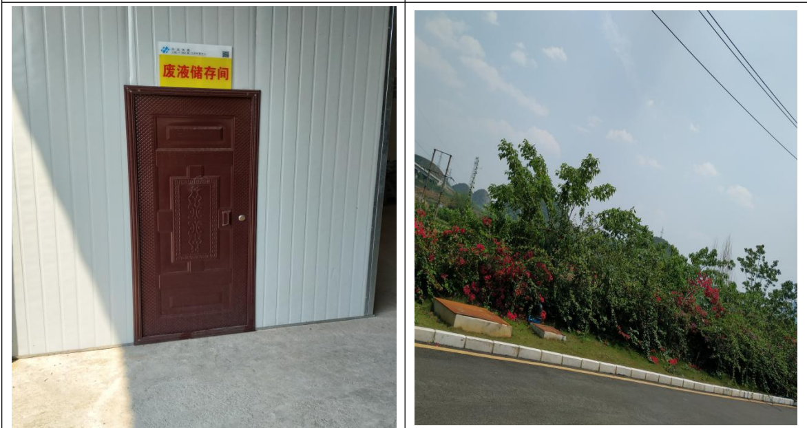
危险液体暂存间
