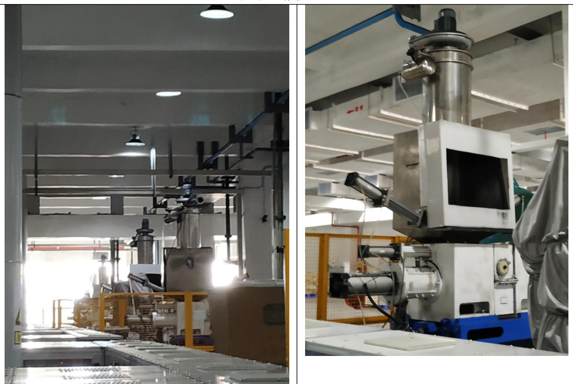
装钵除尘设备
