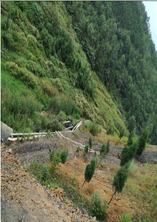
矸石场淋溶水收集池
