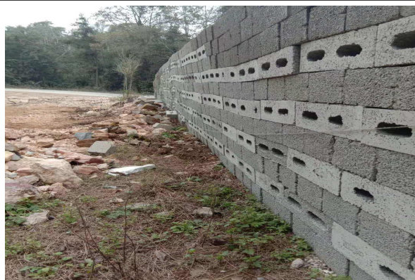
厂区东南侧围墙
