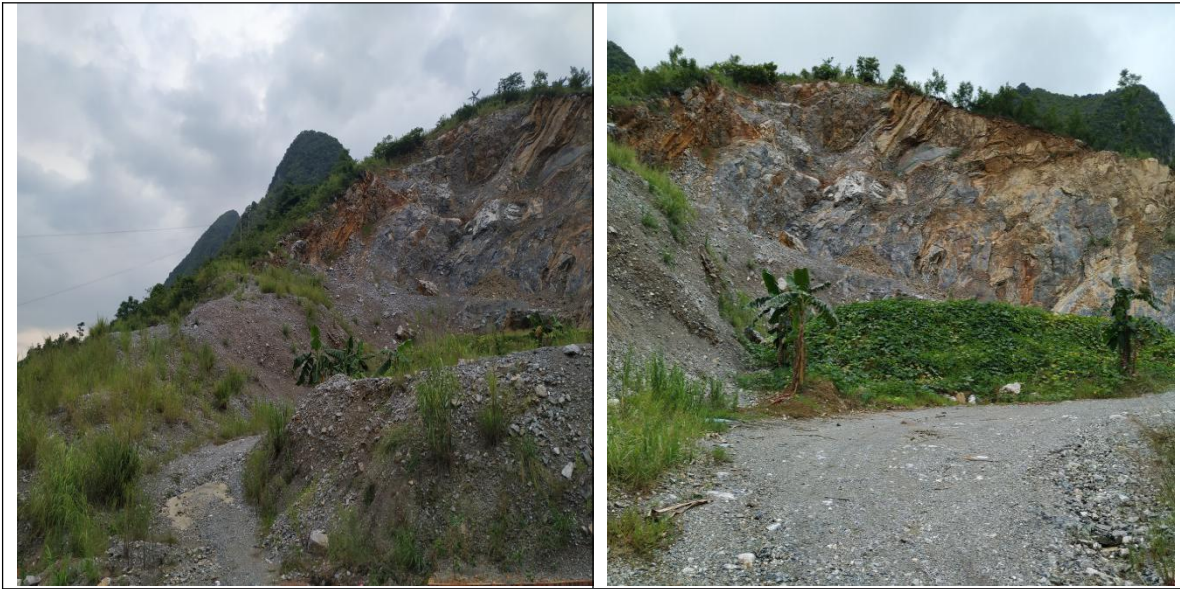
取料场植被恢复情况
