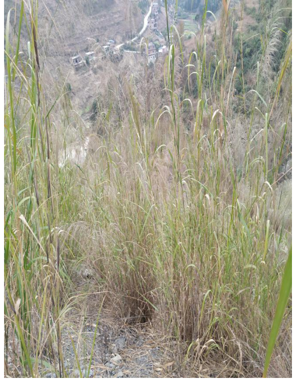
渣场植被恢复情况 K48+320
