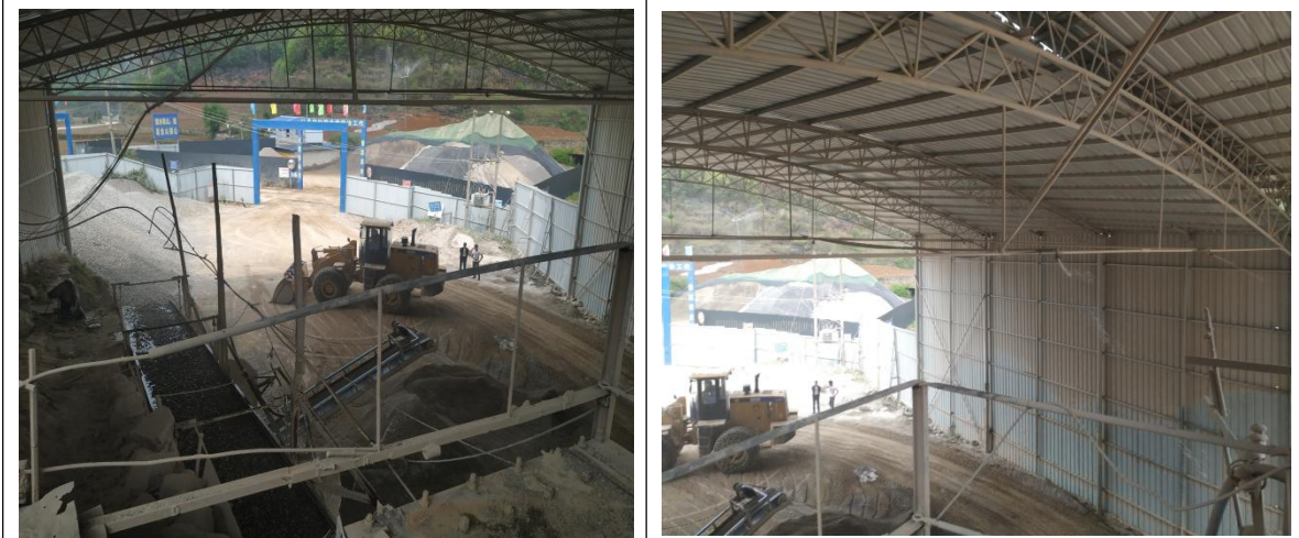
项目生产区厂房及喷淋设施
