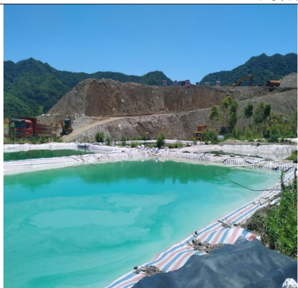
3#堆浸场循环水池
