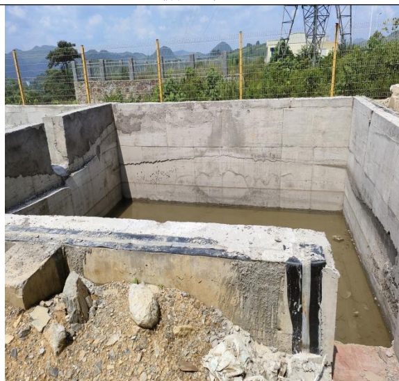
初期雨水收集池
