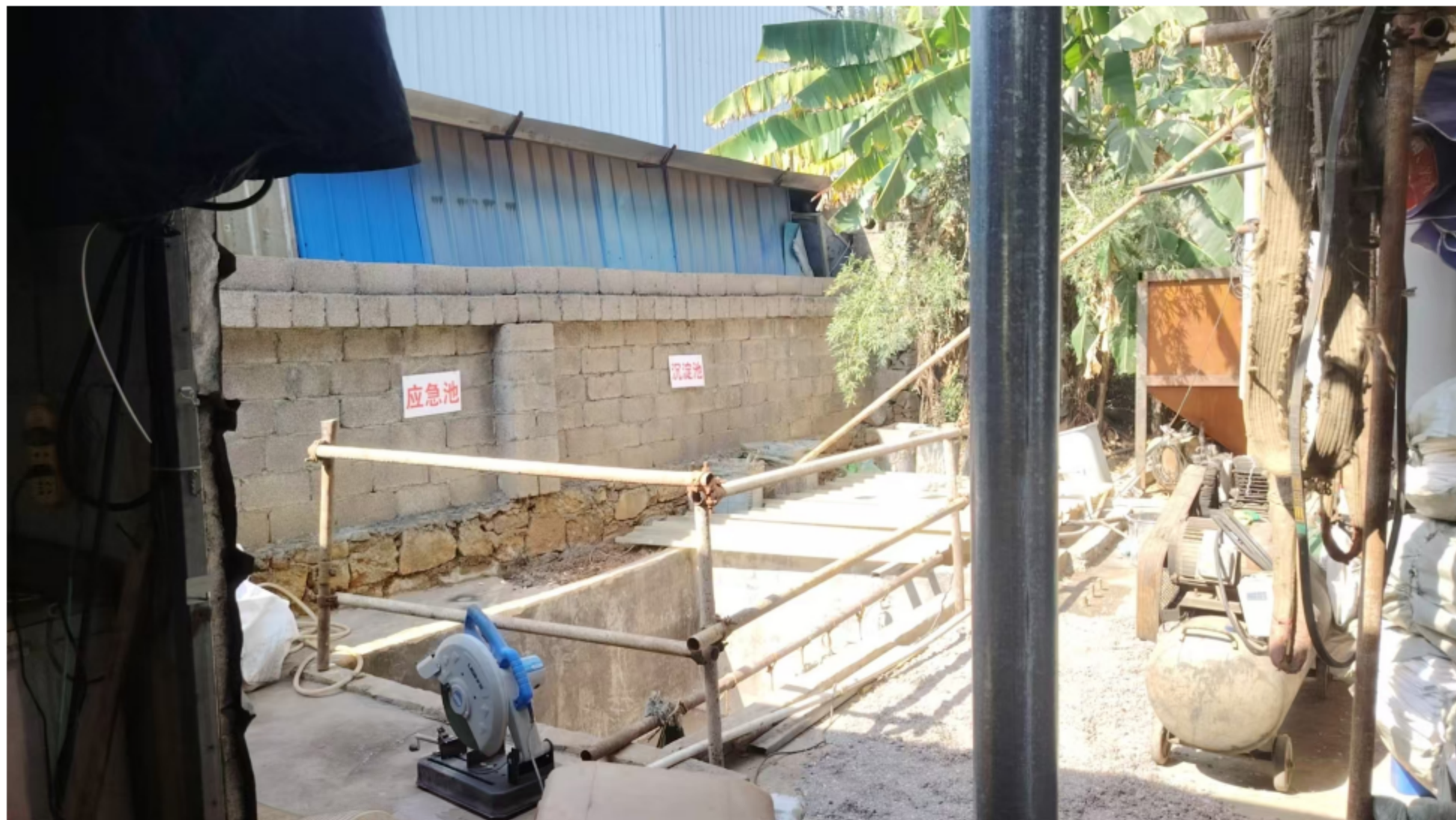
附图 5-1 沉淀池、应急池
