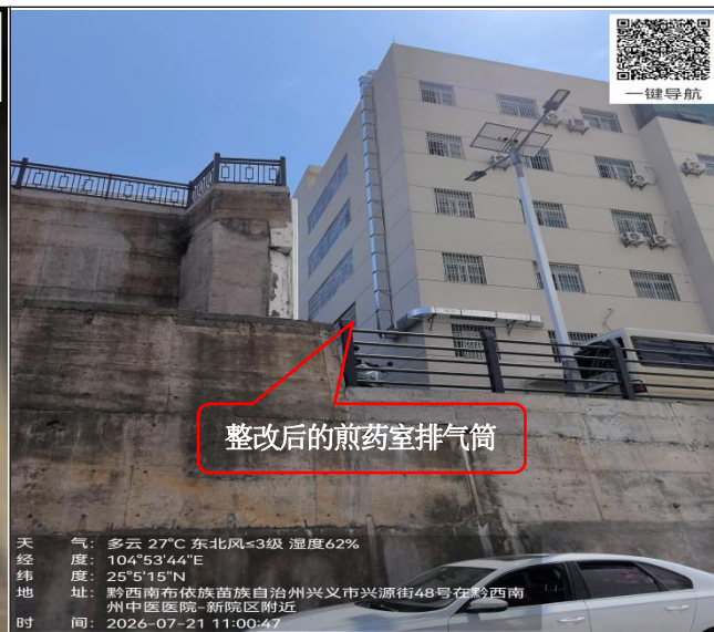
煎药室废气处理排气筒
