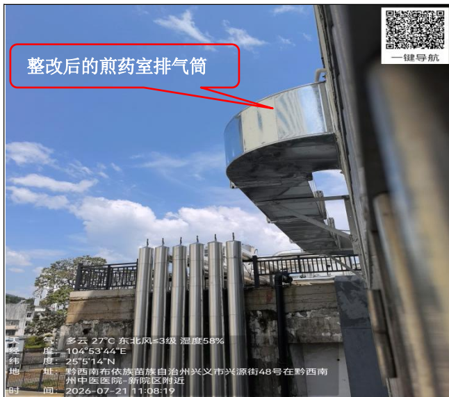
煎药室废气处理排气筒
