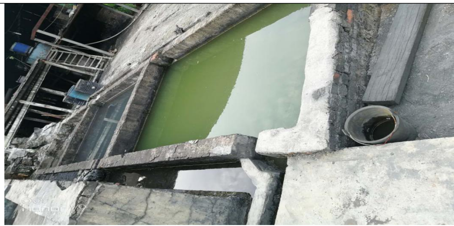
项目循环水池
