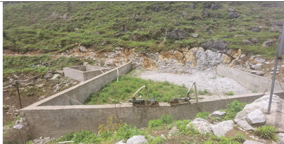
项目尾矿库沉淀池及应急池
