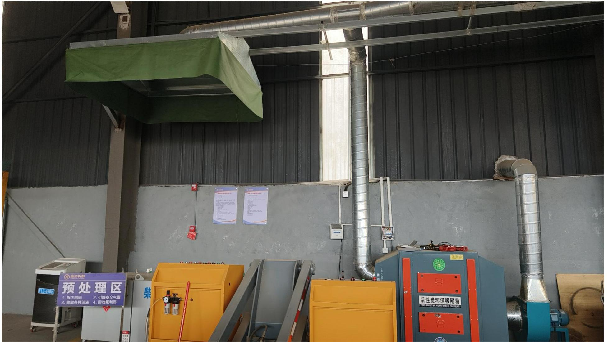
附图 5-6 有机废气净化系统
