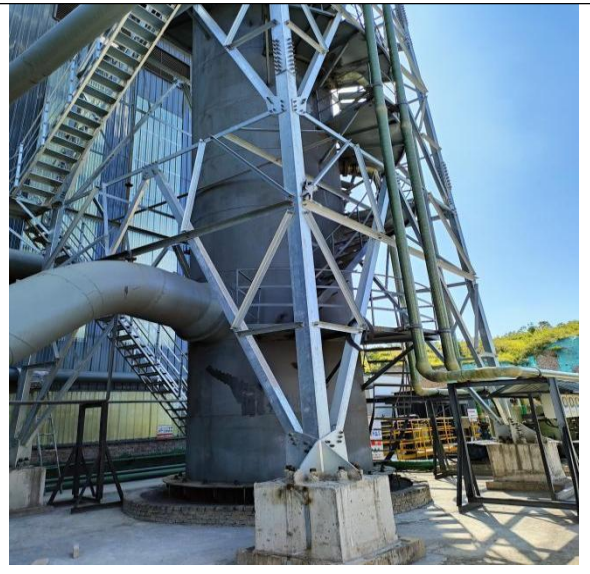
矿热炉脱硫塔
